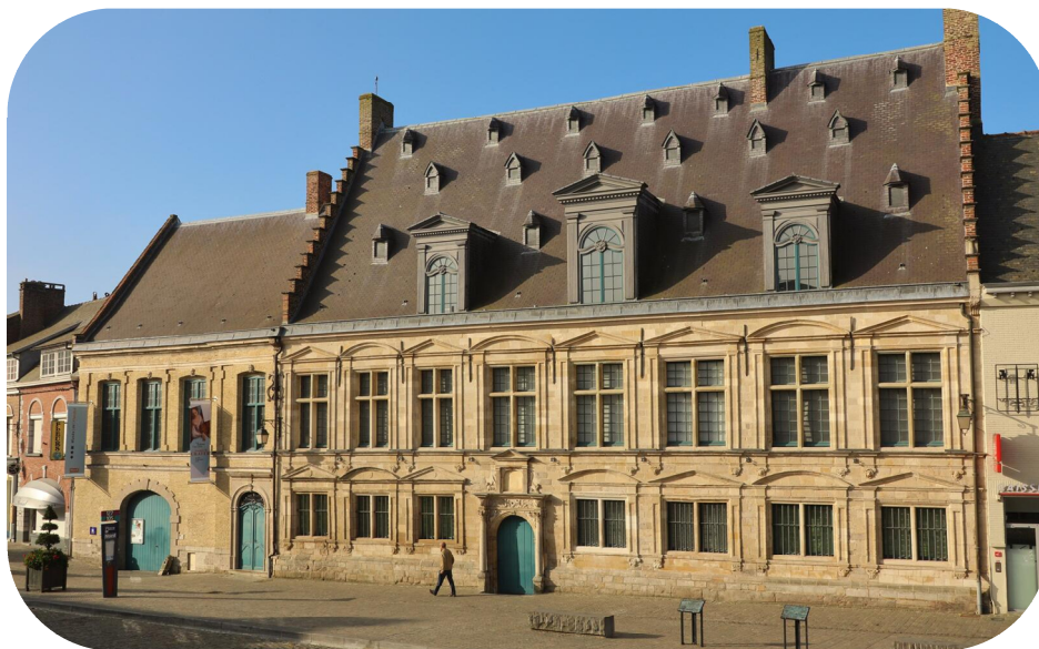
Photo n° 1 : Façade du musée de Flandre
